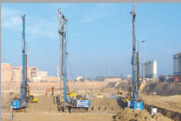
پروژه تحکیم بستر یوشهر
