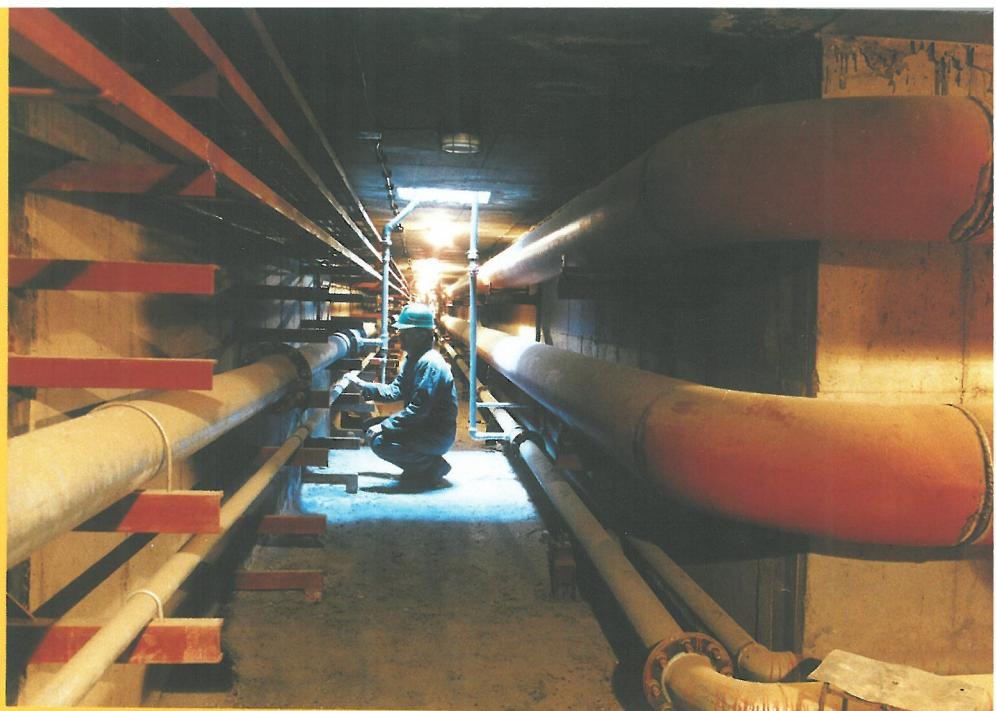
در طرح جامع دانشگاه شاهد یک موتورخانه مرکزی با تجهیزات پیشرفته از جمله دو دستگاه دیگ بخار و دو دستگاه چیلر جذبی پیش بینی گردیده است. این موتورخانه به وسیله یک کanal تاسیساتی آدم رو به طول ۱۰۰ متر ساختمانهای مختلف دانشگاه را سرویس می دهد.
